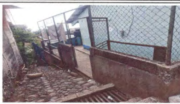
FOTO 8: APLICACION DE PINTURA EN EXTERIORES PERIMETRO COMPLETO TRES LADOS.
