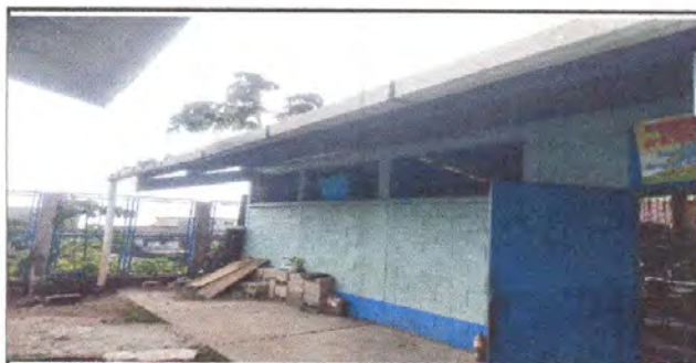
Foto 6: SUSTITUCION DE CANAL DE METAL EN LA PARTE INTERIOR DEL ESTABLECIMIENTO.
