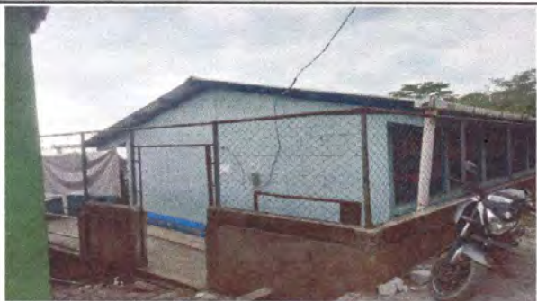
FOTO 9: APLICACION DE PINTURA EN EXTERIORES DEL ESTABLECIMIENTO.
