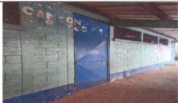
FOTO 7: APLICACION DE PINTURA EN INTERIORES Y EXTERIORES TRES AULAS INTERIOR Y EXTERIOR.
