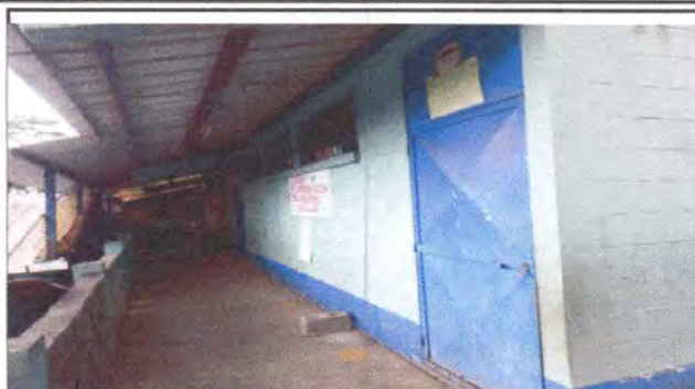
Foto 2: MANTENIMIENTO A ESTRUCTURA (LIJADO, CEPILLADO, SUJECIONES, APLICACIÓN DE PINTURA A PUERTAS 3 AULAS.
