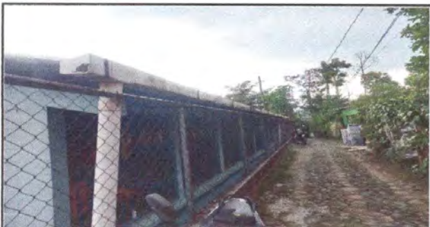
Foto 5: SUSTITUCION DE CANAL DE METAL EN LA PARTE DELA ENTRADA DEL ESTABLECIMIENTO.
