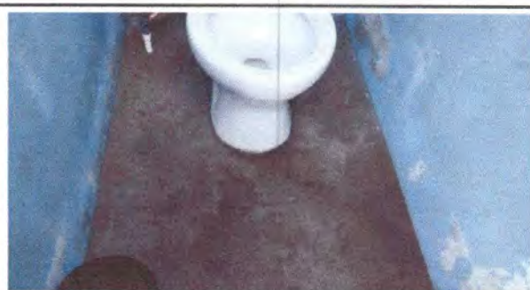
Foto 4: COLOCACION DE AZULEJO A LAS PAREDES Y PISO CERAMICO DE LOS SANITARIOS.
