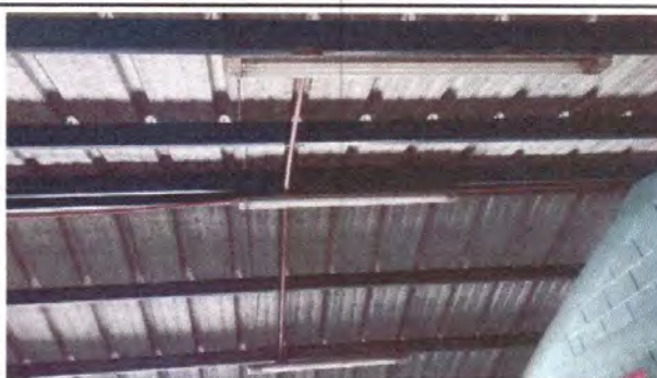
FOTO 10: REPARACION DE LAMPARAS.
