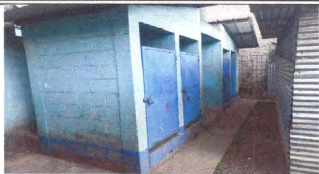
FOTO 1: MANTENIMIENTO A ESTRUCTURA (LIJADO, CEPILLADO, SUJECIONES, APLICACIÓN DE PINTURA A PUERTAS DE BAÑOS.
