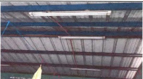
FOTO 11: REPARACION DE LAMPARAS.
